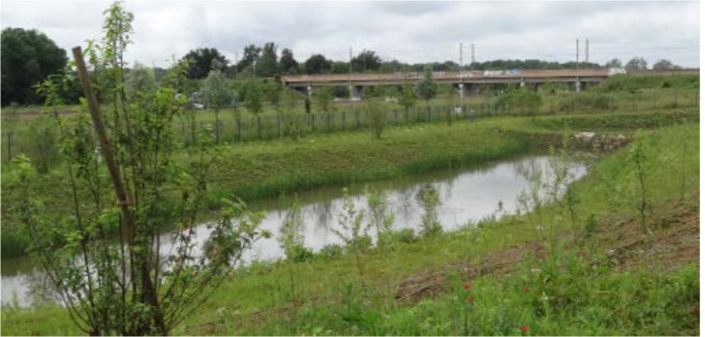
▼ Exemple d'un bassin d'infiltration sinueux végétalisé - photo ©PAYET
